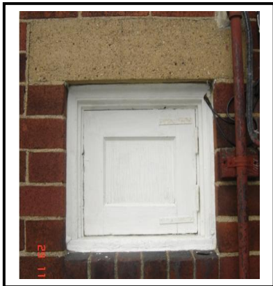
Coal chute door
